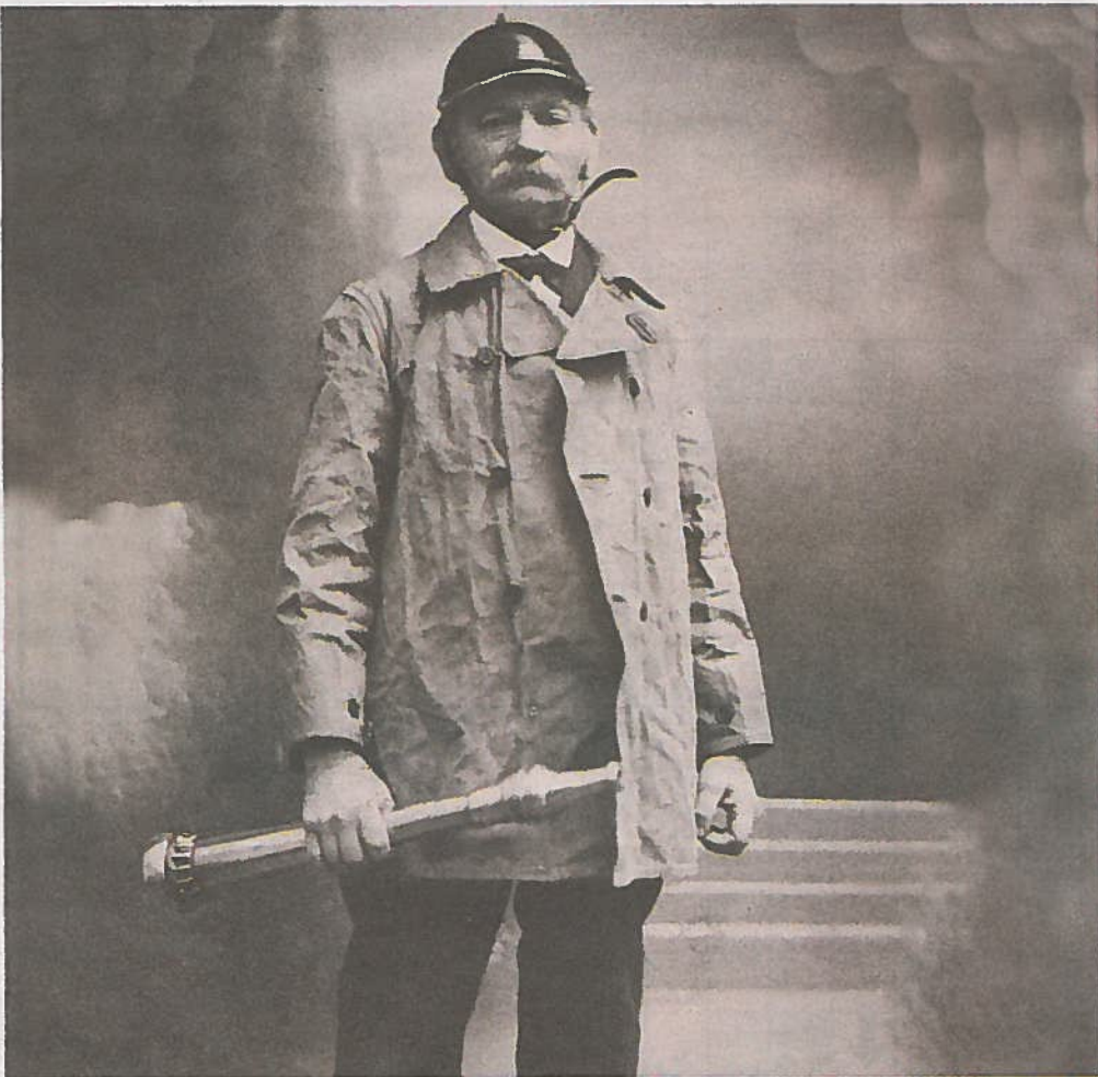
RESERVEMANNSKAP I BRANNVESENET: Bernard Børresen med bare strålerøret. Brannslangen, som var av lær, brant pga. dårlig vanntrykk.
