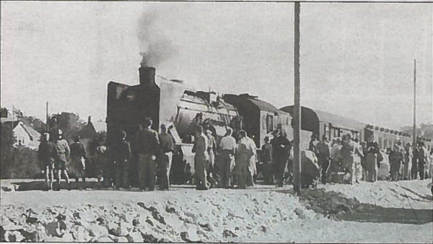
"Jarlsbergsvarten" var en daglig kjøring på Vestfoldbanen før 1957. Damplokomotivet passerte under Bugårdsbrua, og av og til om vinteren forsøkte noen rakkerfanter å kaste snøballer ned for å treffe skorsteinen.
