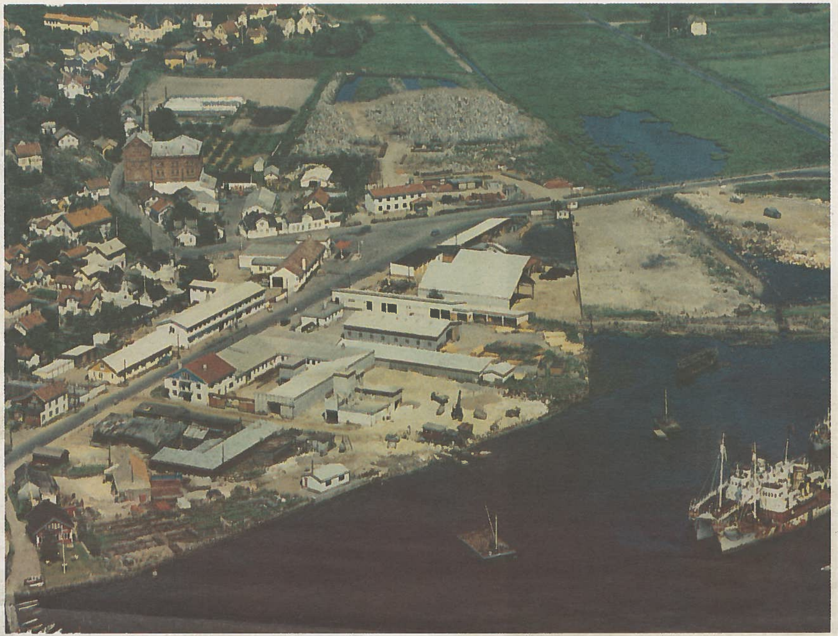
Slik var Kamfjordkilen, Breili og llt av Grønli for bare få tiår siden. Store arealer var rett og slett sump, som gradvis ble fylt opp med søppel og fyllmasse for å bli til industriområde. Legg merke til de nesten bilfrie gatene. Og se, det ligger ett enslig hus i høyre kant, langs Hegnaveien.
