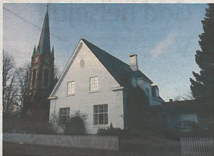
Sverre og Mary Valens ungdomstilvilla i Stockflethsgate 9. ble bygget for skipsreder og verkseier Chr. Christensen i 1915.
