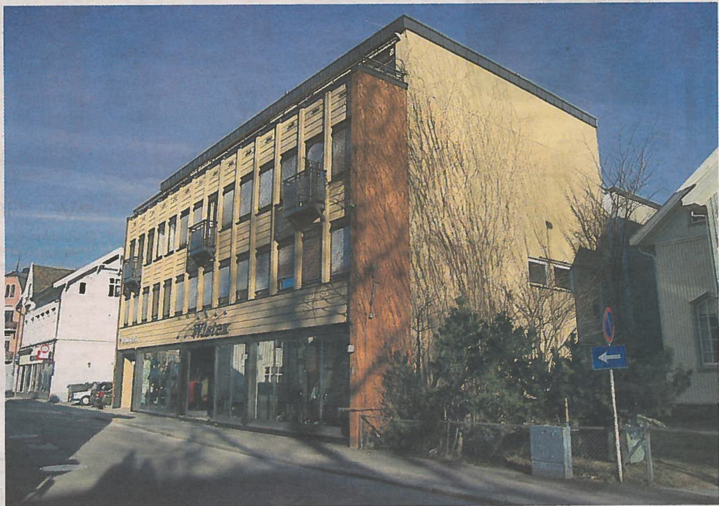
BYGD OM: Foreningens bygg i Sentrum ble satt opp i 1964, og en ny og tiltalende fasade kom i 2000. Man valgte da også å bygge om 3. etg til leiligheter, pluss en tilbaketrukket 4. etg. Samtidig ble det installert heis i trappeløpet og alle rom ble oppgradert/oppusset.
