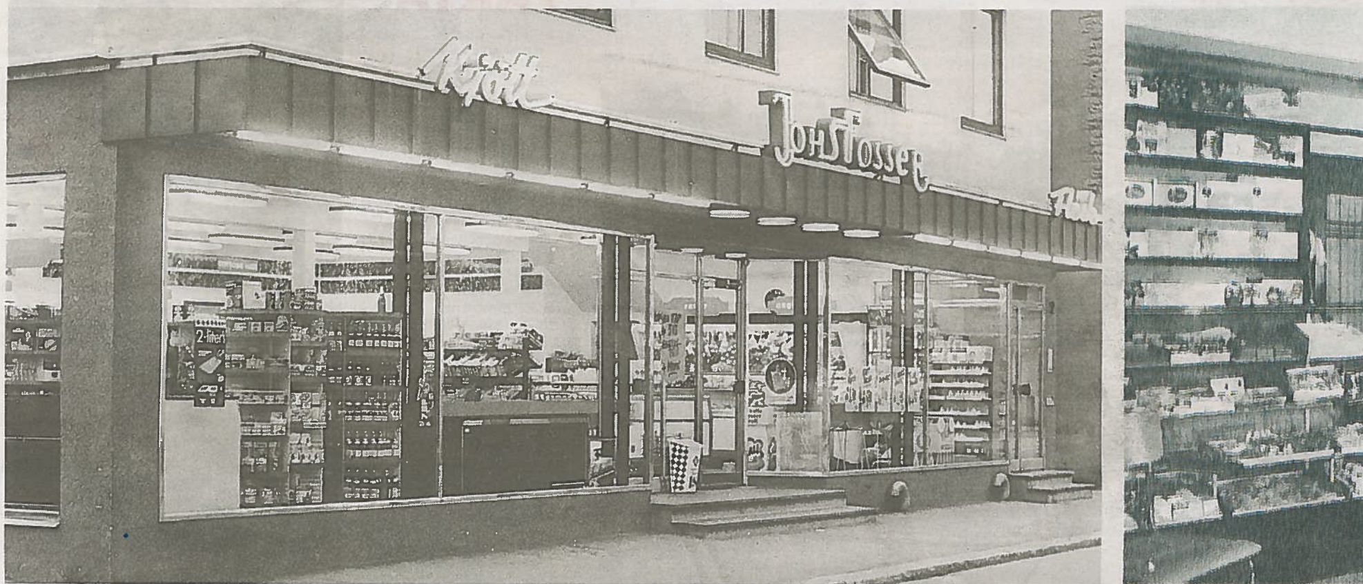
KJØTTBUTIKKEN: Johs Fossers hovedforretning i Stockfleths gate 2, Fossers-gården, var trolig den flotteste kjøttbutikken Sandefjord noensinne har hatt. Bildet tatt i 1966 er fra Jorunn Fossers Hunnskaar og Svein Hunnskaars samling, og kan også ses sammen med 18 andre Johs Fossers-bilder i Sandefjord Lokalhistoriske Senters bildebase på internett.
