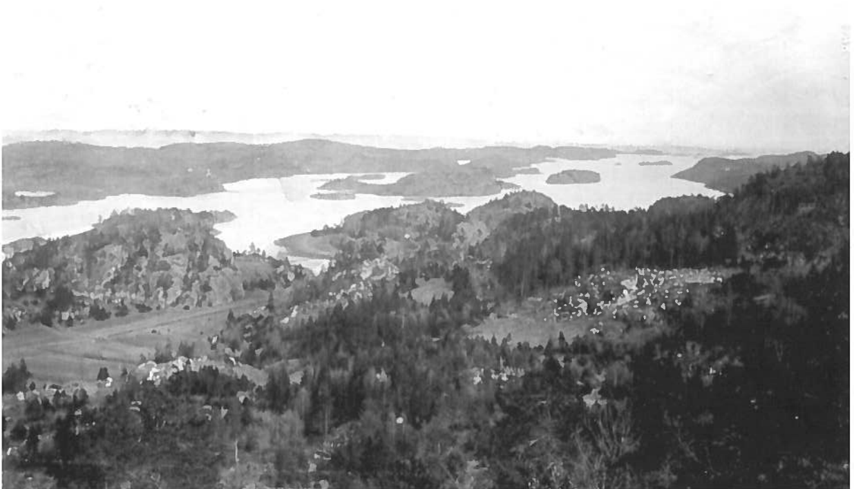
Slik så skytebanen og området rundt ut ca 1920. Helt til 50-årene var det ingen bebyggelse nær opptil, men en kraftgate med høyspentledning ble anlagt, og denne måtte skytterne ta hensyn til. Foto utlånt av Sandefjordsmuseene
